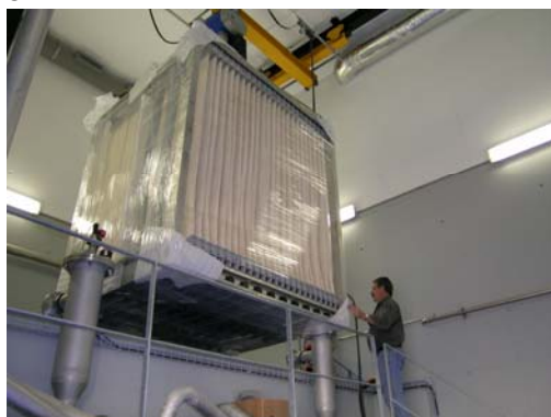
Bild 3. Einbringung der Membrankassette für die Schwemmwasseraufbereitung
