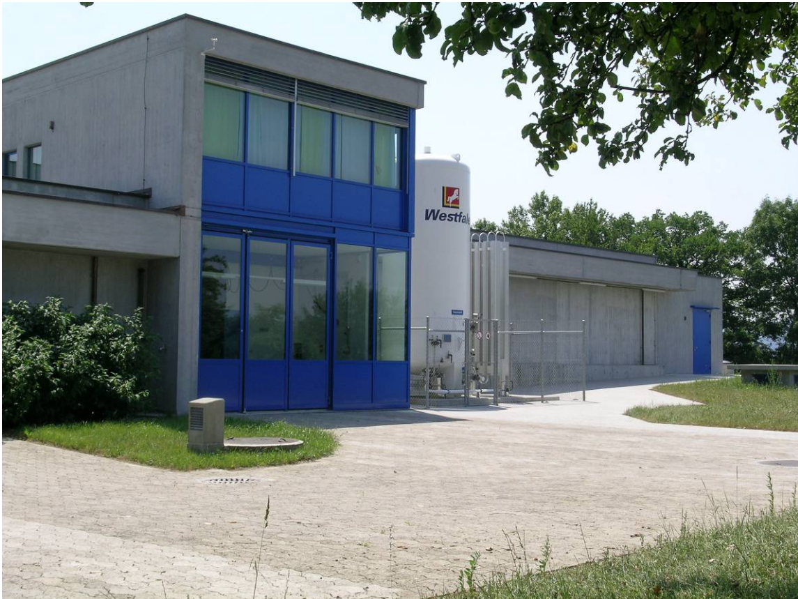
Abb. 5: Renovierte Gebäude und neuer Ultrafiltrationsanbau (ganz rechts) des SWW Meilen
