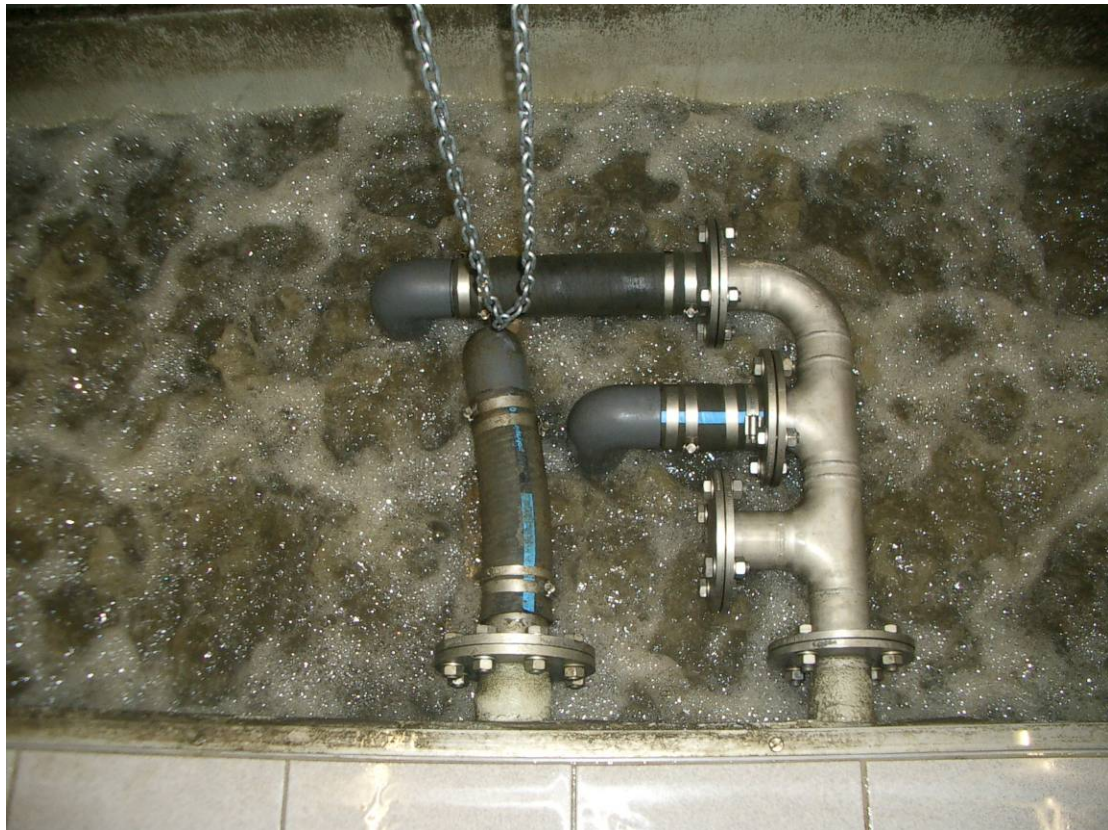
Abb. 6: Ultrafiltrationsbetrieb der getauchten Membran, SWW Meilen
